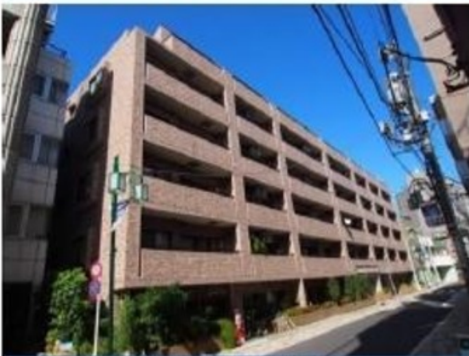
タイル貼りの建物外観
