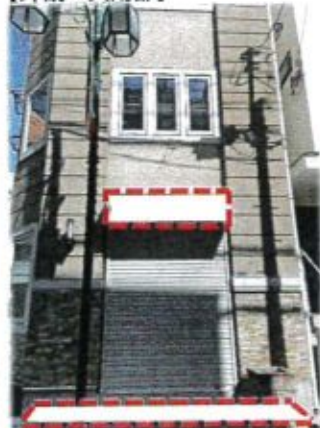
【外観・共用部】
